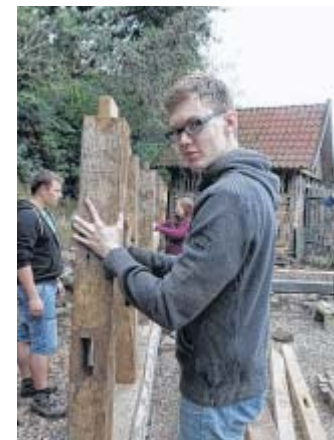
Auf der Baustelle: Leon Hauck richtet einen Ständer aus.
