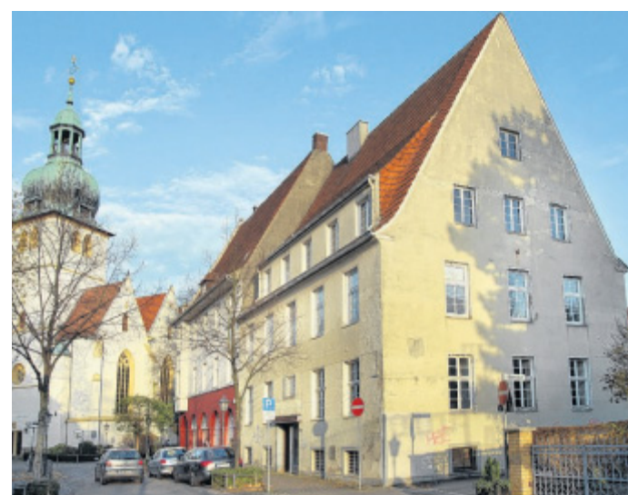
Bielefelder Straße 1a: Das Wohn- und Geschäftshaus soll zu einem reinen Wohnhaus umgebaut werden.
