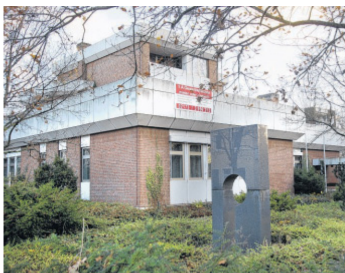
Ehemalige Landeszentralbank: Sie soll drei modernen Wohnhäusern mit hohem energetischem Standard weichen.
