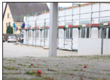
Handwerker arbeiten derzeit am Gebäude des künftigen Psychosozialen Zentrums.
