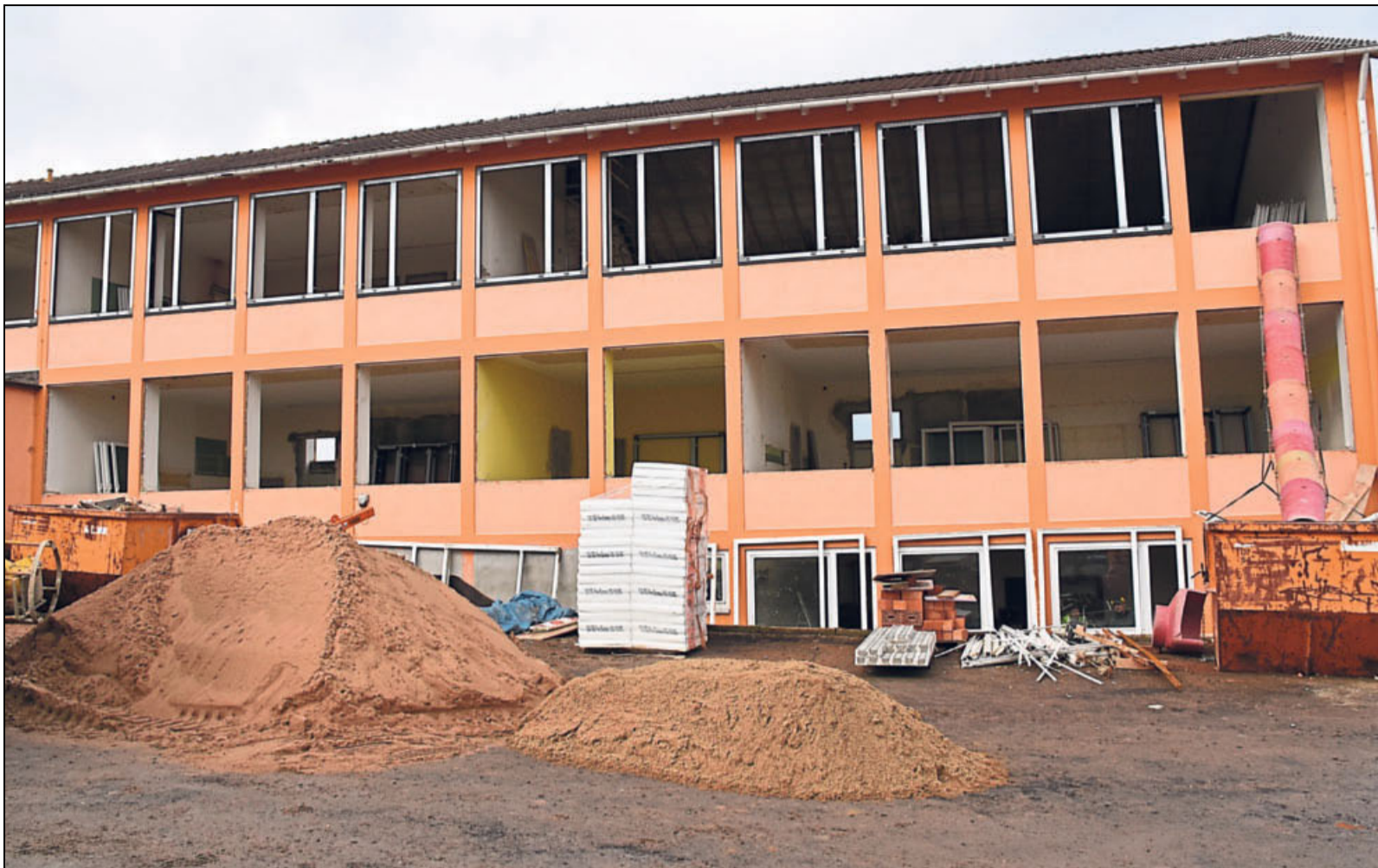
Das Gebäude der ehemaligen Grundschule auf dem Wittel ist momentan eine Baustelle. Mitte des Jahres will das Architekturbüro Podufal-Wiehofsky in die renovierten Räume umziehen. Aktuell werden neue Fenster mit spezieller Verglasung eingebaut. Fotos: Philipp Bülter
