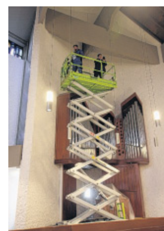
Schwindelfrei: Die letzten Arbeiten in der Höhe.
