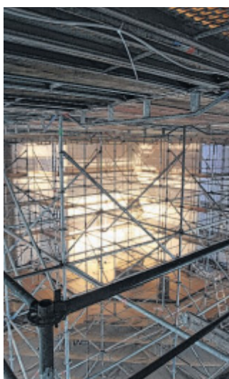
Eingerüstet: So sah es einige Wochen lang im Inneren aus.
