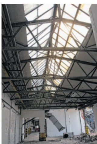
Typisch: Die aufgesetzten Fenster nannten sich Schedlichter.
