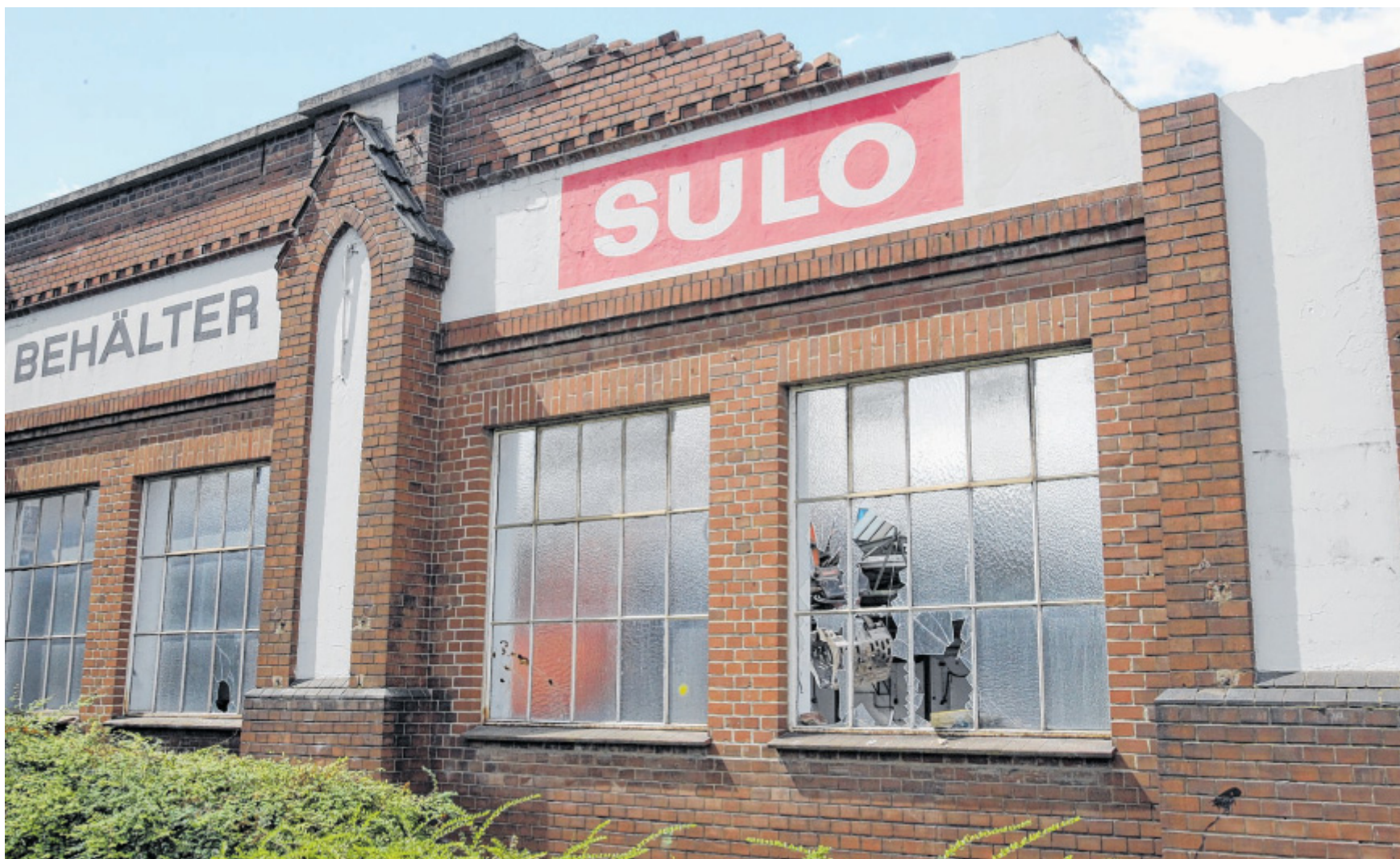
Nostalgisch: Mehr als 100 Jahre prägte das Bild der Produktionshallen das Bild an der Bündler Straße. Zunächst war die Möbelfabrik Kopka hier aktiv, in den 1950-er Jahren zog Sullo ein. Da das Gebäude nicht unter Denkmalschutz steht und einsturzgefährdet ist, wird es jetzt abgerissen.
