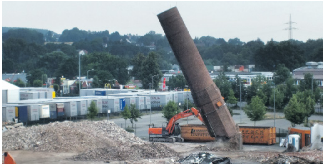
Er fällt: Genau um 8.23 Uhr küsst der Schornstein den Boden, sagt Fotograf Ralph Prüfner. Bis zur letzten Sekunde hat der Bagger dem Turm Stückchen für Stückchen den Sockel abgeknabbert. In dem Augenblick, den Prüfner hier festgehalten hat, befindet sich das Baufahrzeug in eiliger Rückwärtsfahrt.
