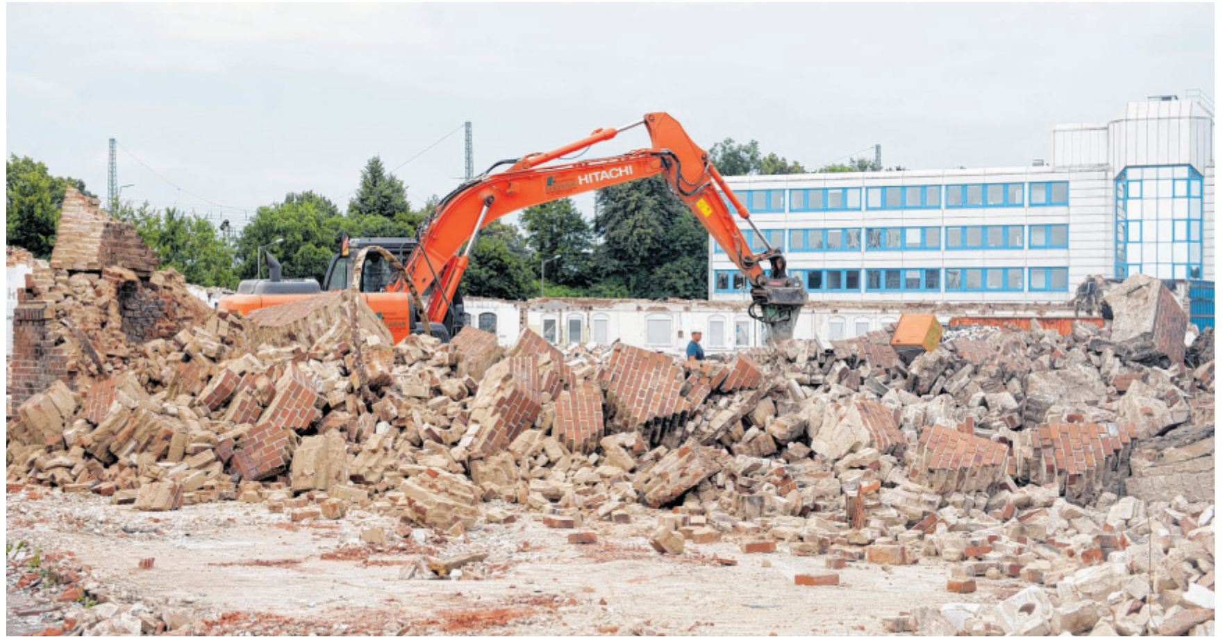
Da liegt er: Am Samstagmorgen wurde der Schornstein des alten Sulo-Werkes abgerissen. An Hand der Trümmer lässt sich die ungefähre Höhe des 1918 errichteten Schornsteines erahnen. FOTOS: RALF BITTNER
