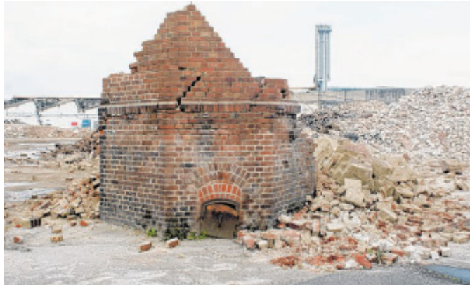
Stumpf: Wie auch die Werkshallen war der Schornstein aus roten Ziegeln errichtet worden.
