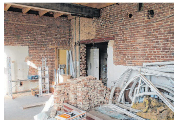
Baustelle: Anja Renken hat den Putz von den Wänden gestemmt. Die alten Kunststoffenster liegen in der Ecke. FOTO: PODUFAL
