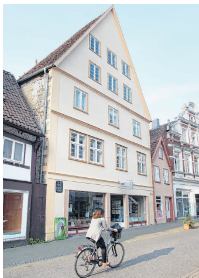
Neue Ansicht: Die Fassade vom Fürstenuhhaus mit den biblischen Schriftzügen auf dem Gurtgesims. FOTO: FRANK-MICHAEL KIEL-STEINKAMP
