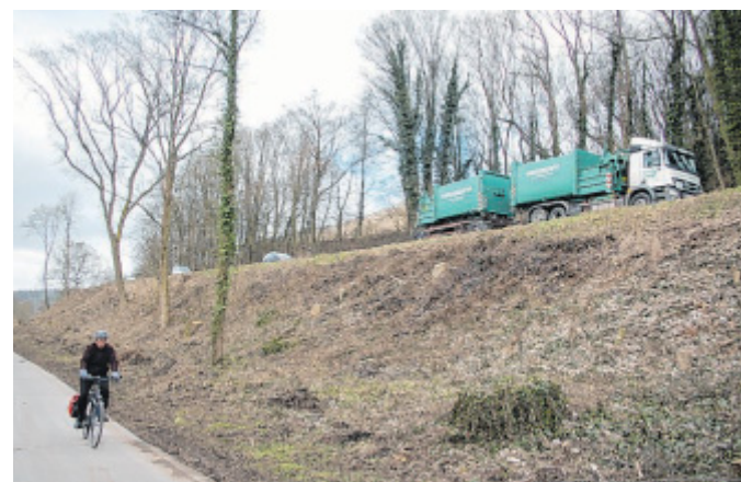
Fallhöhe: Ein Teil der B 61 zwischen Dehme und Barkhausen führt an steilen Böschungen entlang, die nicht gesichert sind. Direkt unterhalb des Abhangs verläuft der Weserradweg. FOTO: DIRK HAUNHORST
