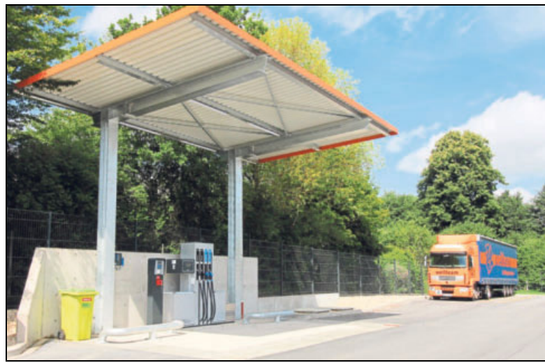
Unterirdische Tankbehälter für 90 000 Liter Diesel wurden an der neuen Tankstelle auf dem Welteam-Areal installiert.
