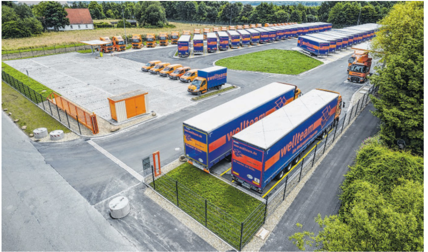
Großflächig: Erst unlängst investierte das Unternehmen 1,4 Millionen Euro in einen 12.000 Quadratmeter großen Lkw-Parkplatz im Industriegebiet Diebrock.
